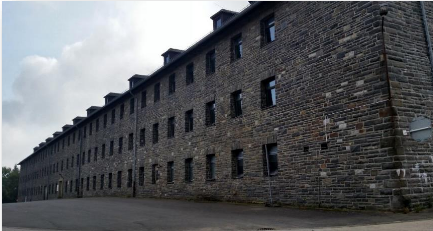
Nicht kleckern – klotzen: 100m lange Gebäudefront (Foto: Hubert Kreuzkamp)
